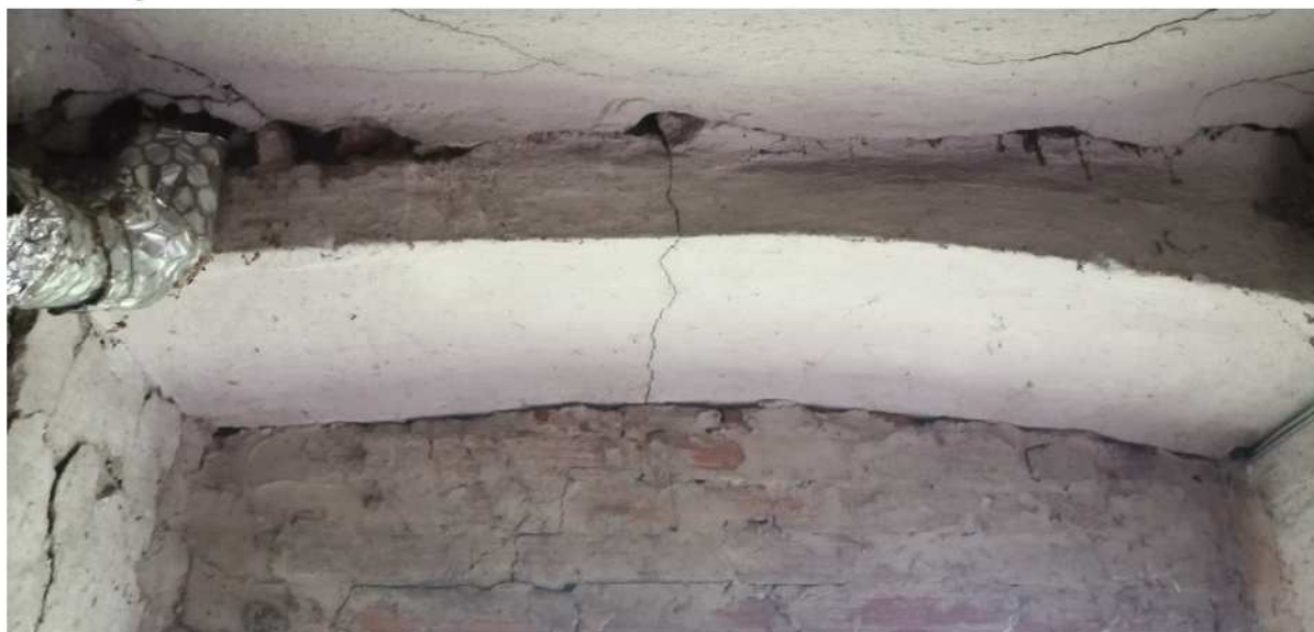
Trhlina v prievlaku
