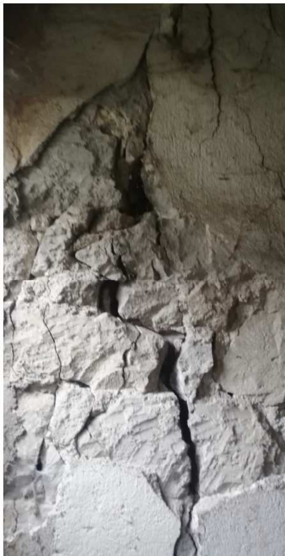
Trhlina v obvodovej stene
