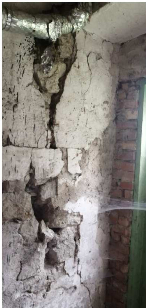
Trhlina v obvodovej nosnej stene
