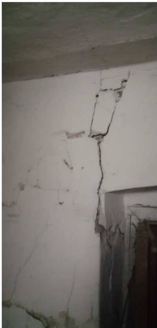
Trhlina vo vnútornej nosnej stene
