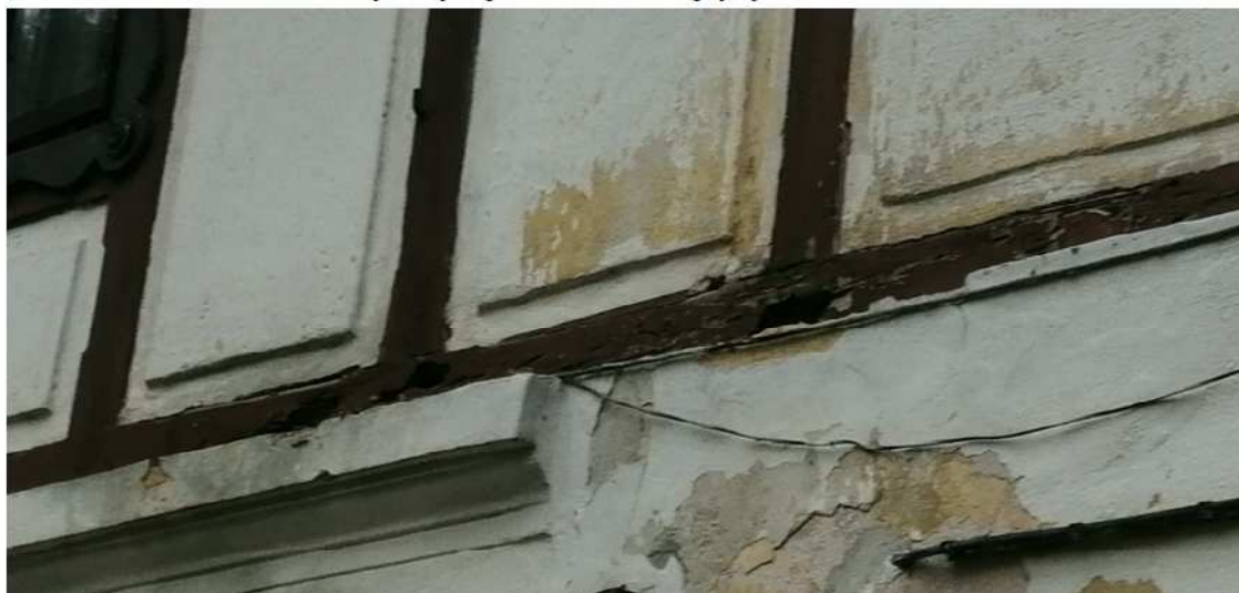
Degradácia hrázdzenia /drevokazný hmyz, poveternostné vplyvy/
